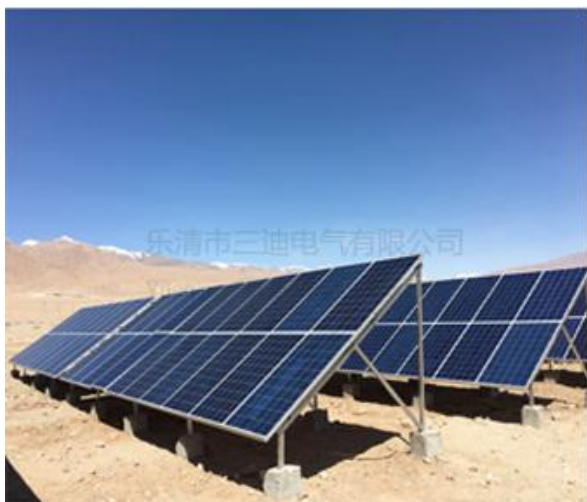
新疆63KW光伏扬水灌溉系统
