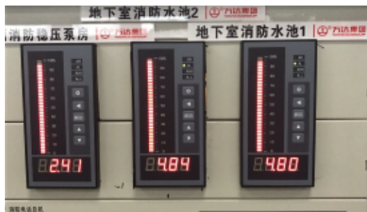
WH311&WH6消防水位控制工程师在现场安装调试
